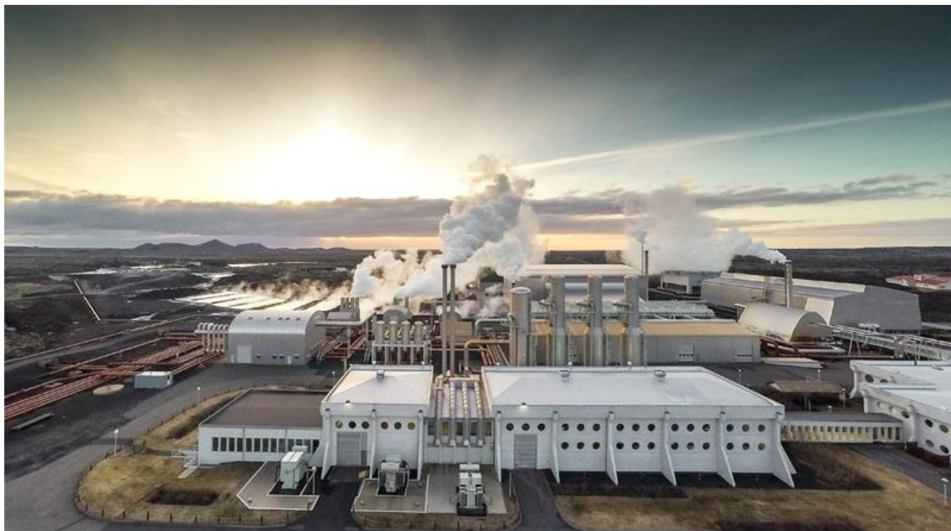
HS-Orka-Kraftwerk. (Foto HS Orka)
