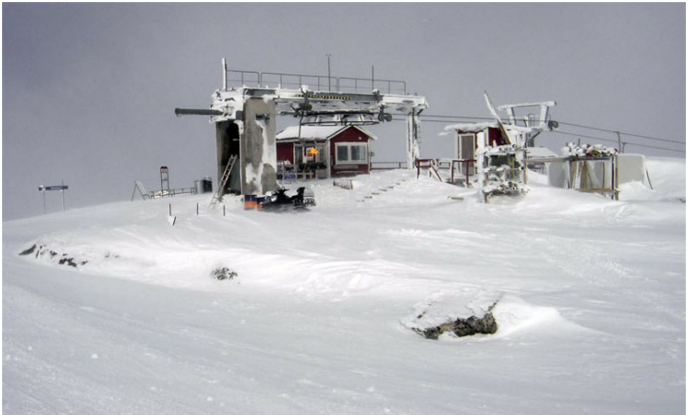
Lift im Skigebiet Riksgränsen. (Foto gemeinfrei)
