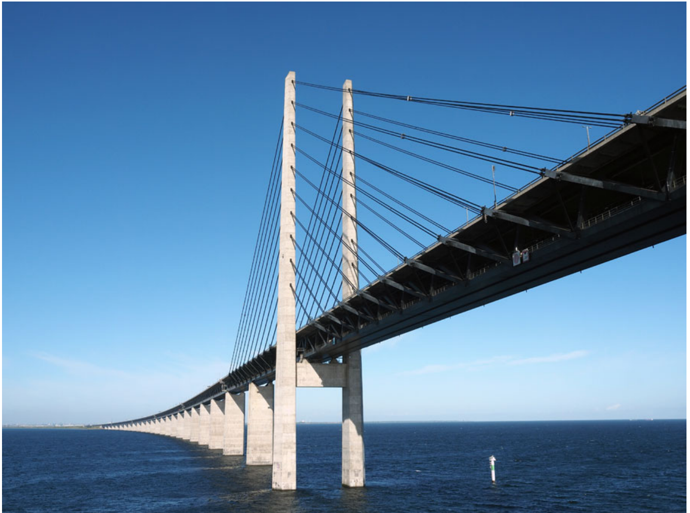
Öresundbrücke in Richtung Kopenhagen. (Quelle Hajotthu)
