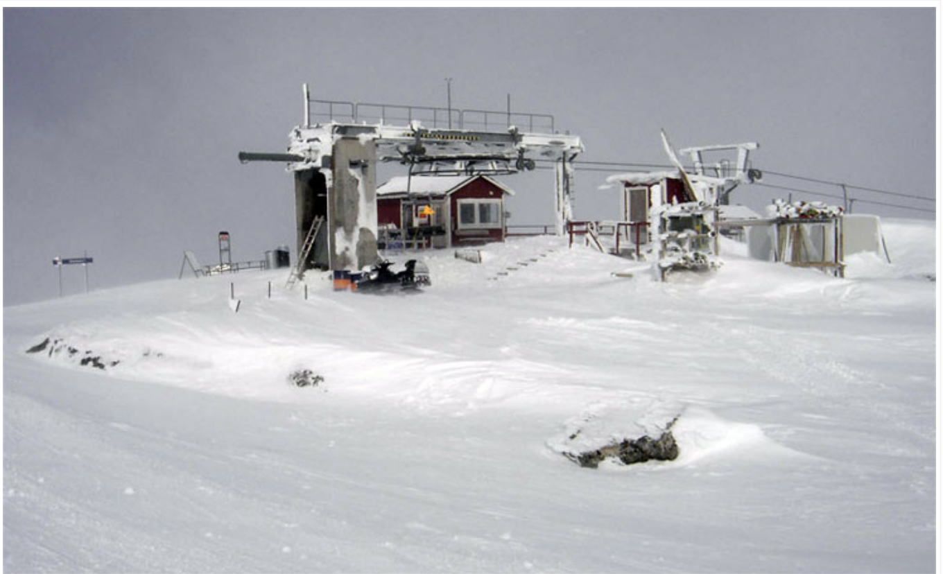
Lift im Skigebiet Riksgränsen. (Foto gemeinfrei)
