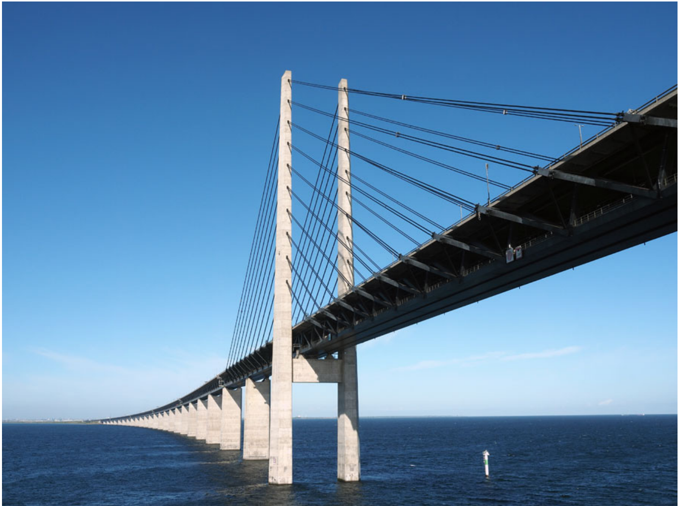
Öresundbrücke in Richtung Kopenhagen. (Quelle Hajotthu)
