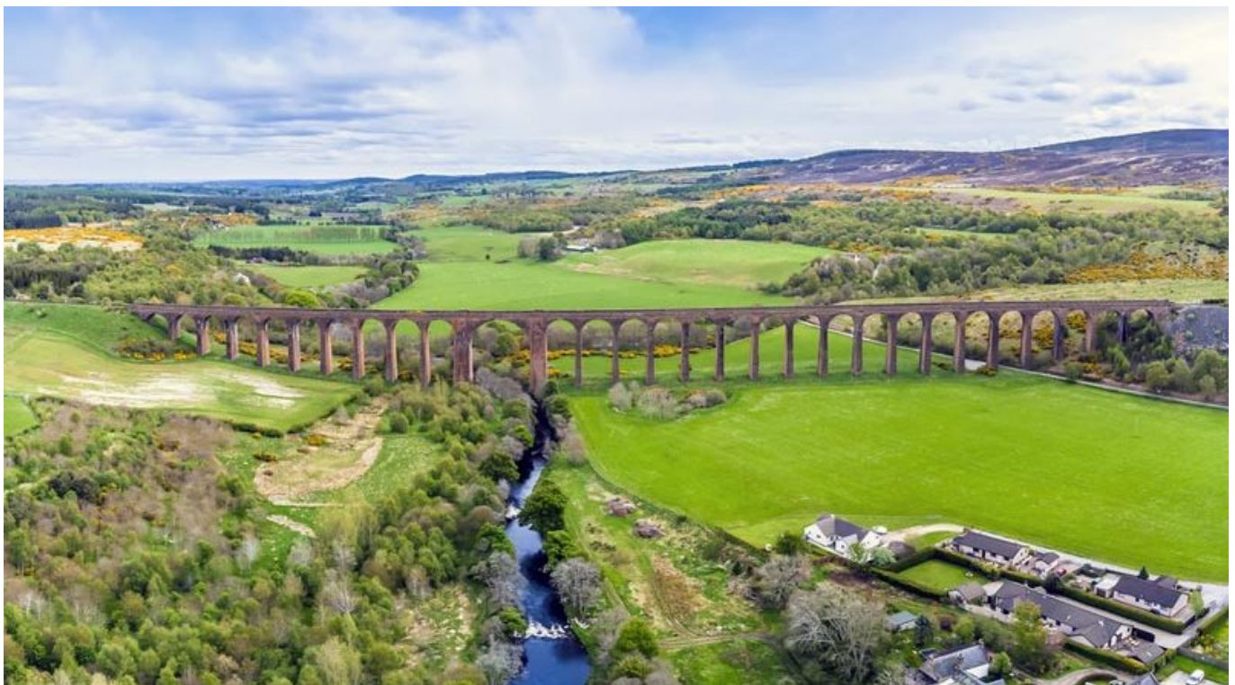
Der Culloden Viaduct ist Teil der Eisenbahnlinie Perth-Inverness.
