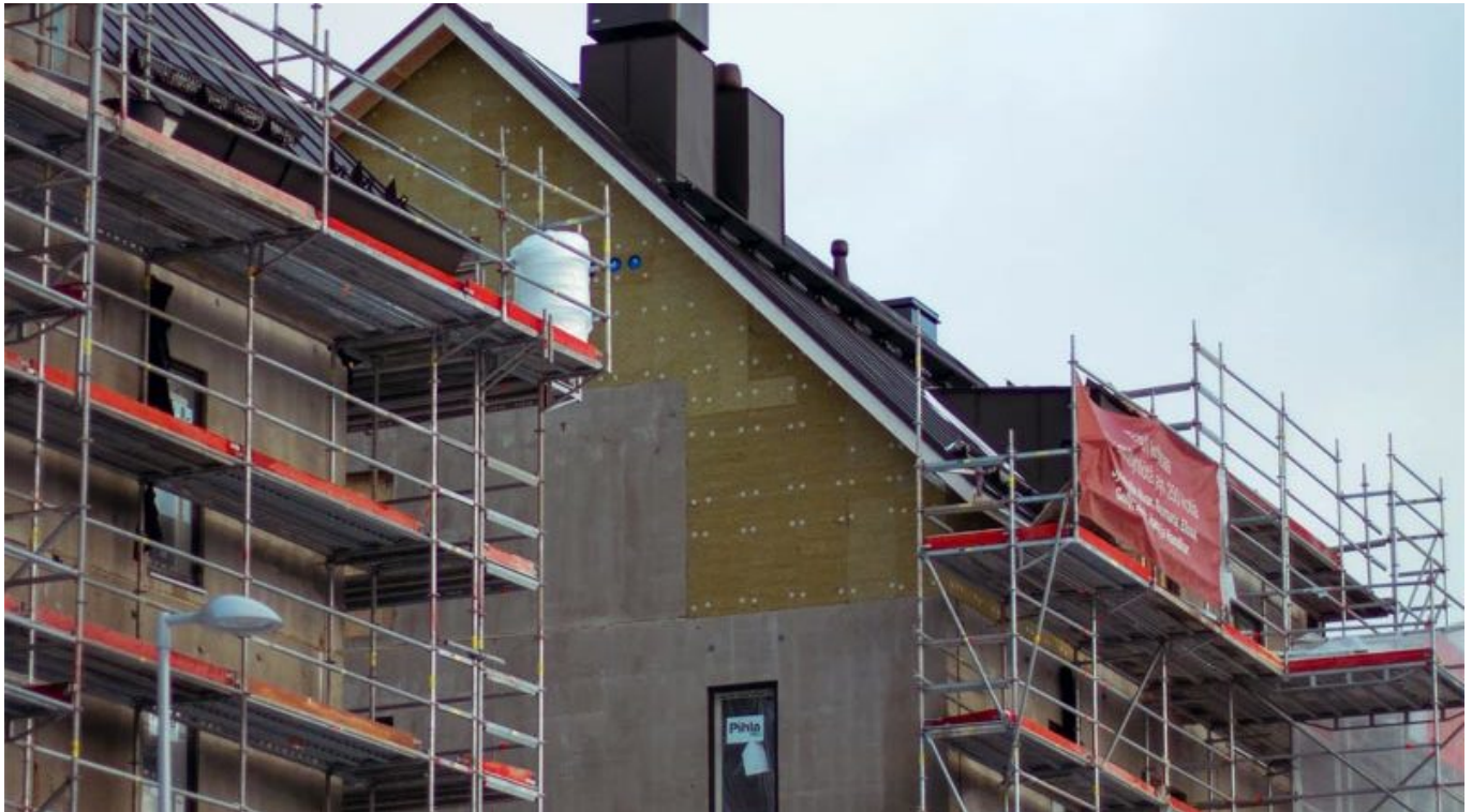
Baustelle in Jyväskylä. (Foto: K8)
