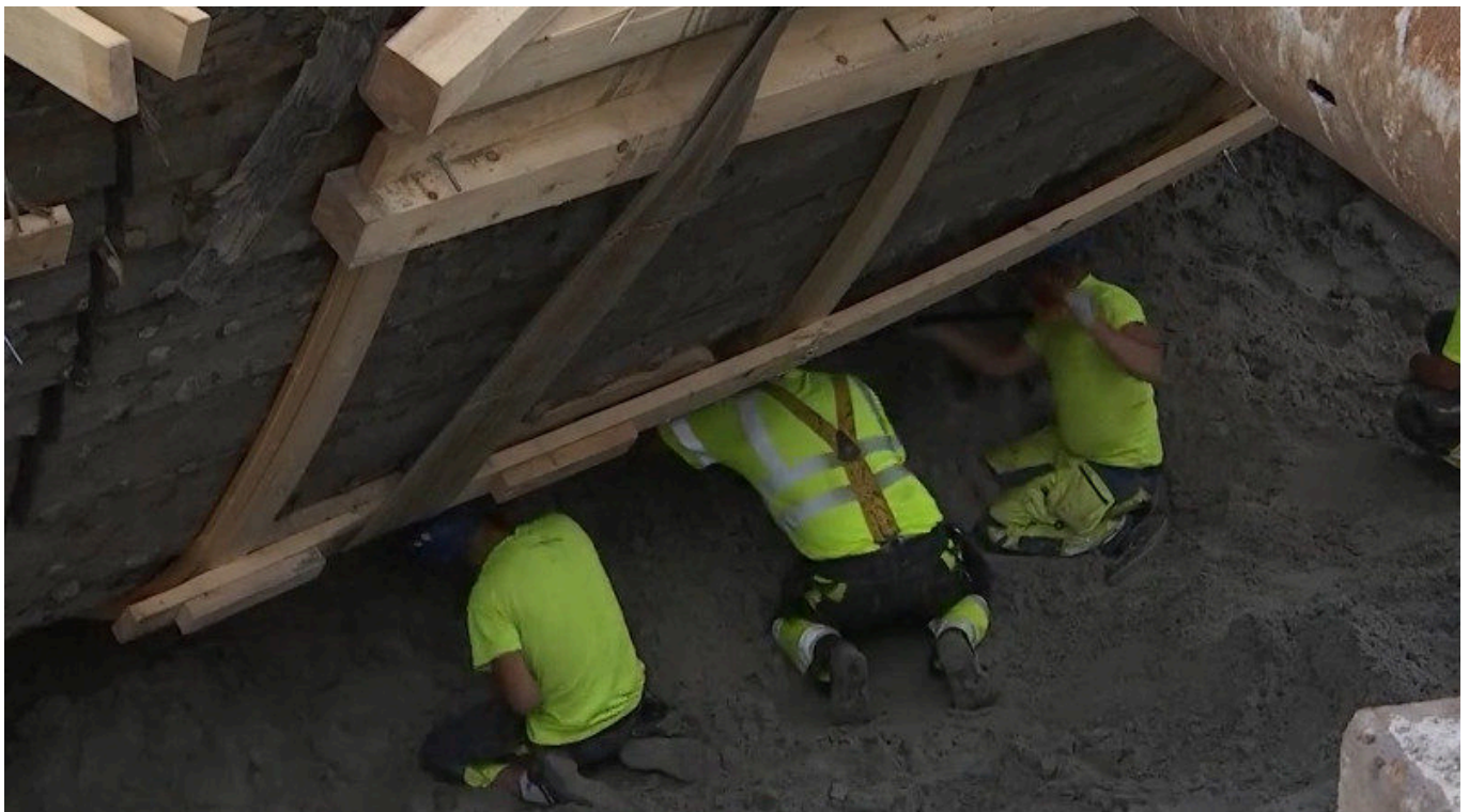
Schwierige Arbeiten im metertiefen Sand. (Quelle: ETV)
