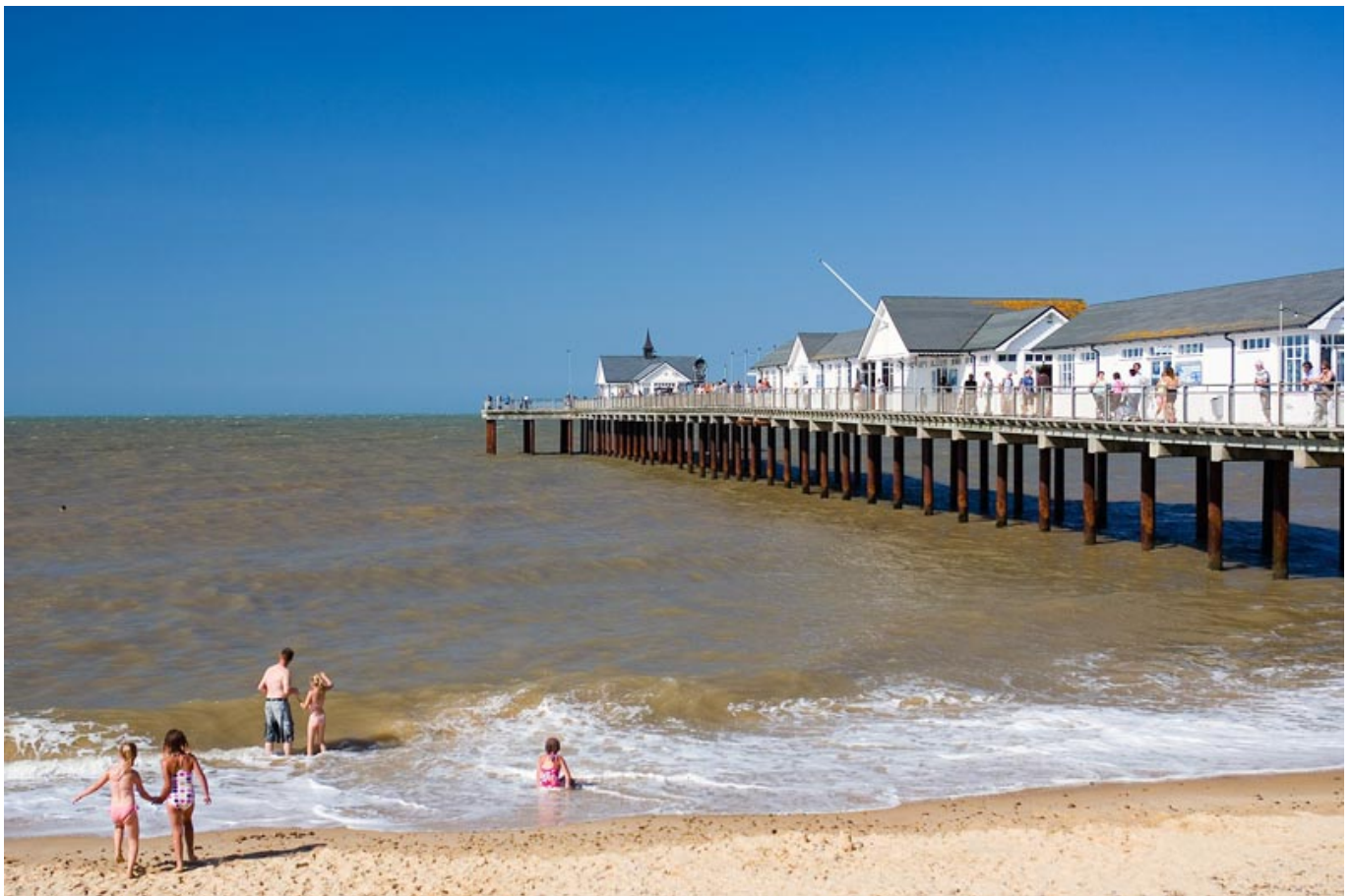
Pier in Southwold im Sommer, Grafschaft Suffolk. (Foto Ron Porter)
