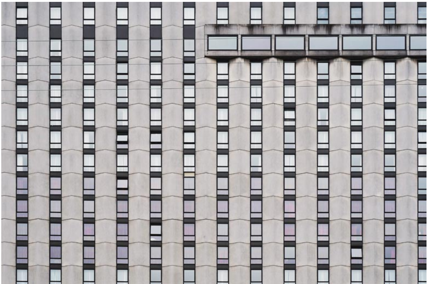
Hochhausfassade am Amager Boulevard, Kopenhagen. (Foto Dmitri Popov)
